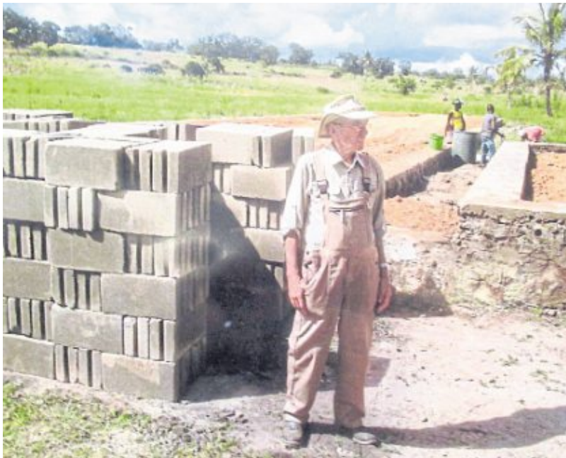
Vor rund vier Jahren hat Eberhard Ströder aus Mogendorf in Tansania den Bau einer Grundschule initiiert (hier während der Bauarbeiten). Jetzt konnten die ersten drei Klassenräume in Betrieb genommen werden. Foto: privat
