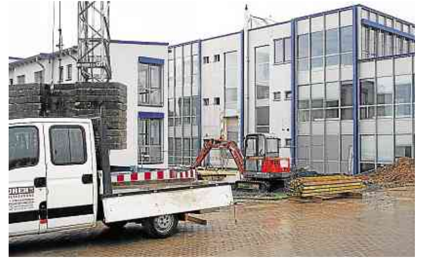
Die Bauarbeiten für das neue Schulgebäude des Privatgymnasiums Raiffeisen-Campus in Wirges sind in vollem Gange. Foto: Stephanie Kühr
